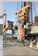
薄壁桩施工
